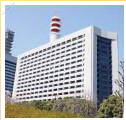
警視庁本部庁舎(26)外壁改修工事(東京都) / 施工:2017年
